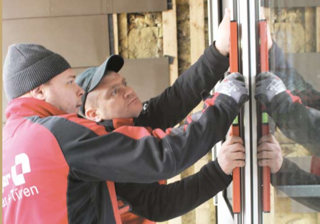
Mitarbeiter der hilzinger GmbH beim Einbau neuer Kunststofffenster im Rahmen der energetischen Sanierung von drei Hochhäusern in Offenburg.
