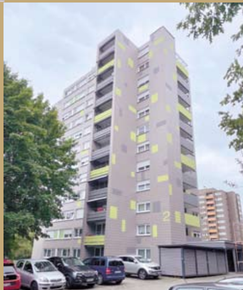
Das erste Hochhaus in der Altenburger Allee in Offenburg ist inzwischen energetisch saniert und mit neuen Kunststofffenstern ausgestattet.
