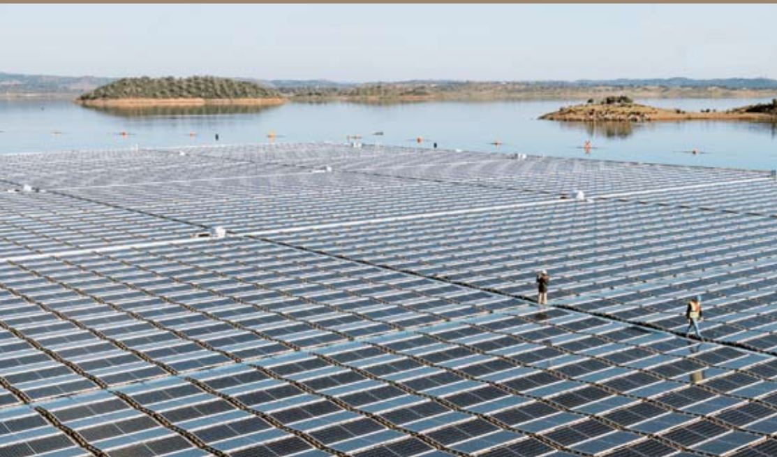
Auf dem Alqueva-Stausee in Portugal ist eine schwimmende PV-Anlage mit über 12.000 Photovoltaik-Modulen entstanden, die mit einem korrosionsbeständigen und für den Außenbereich geeigneten PVC-Kabelführungssystem ausgestattet wurden. Foto: EDP Renewables/Unex
