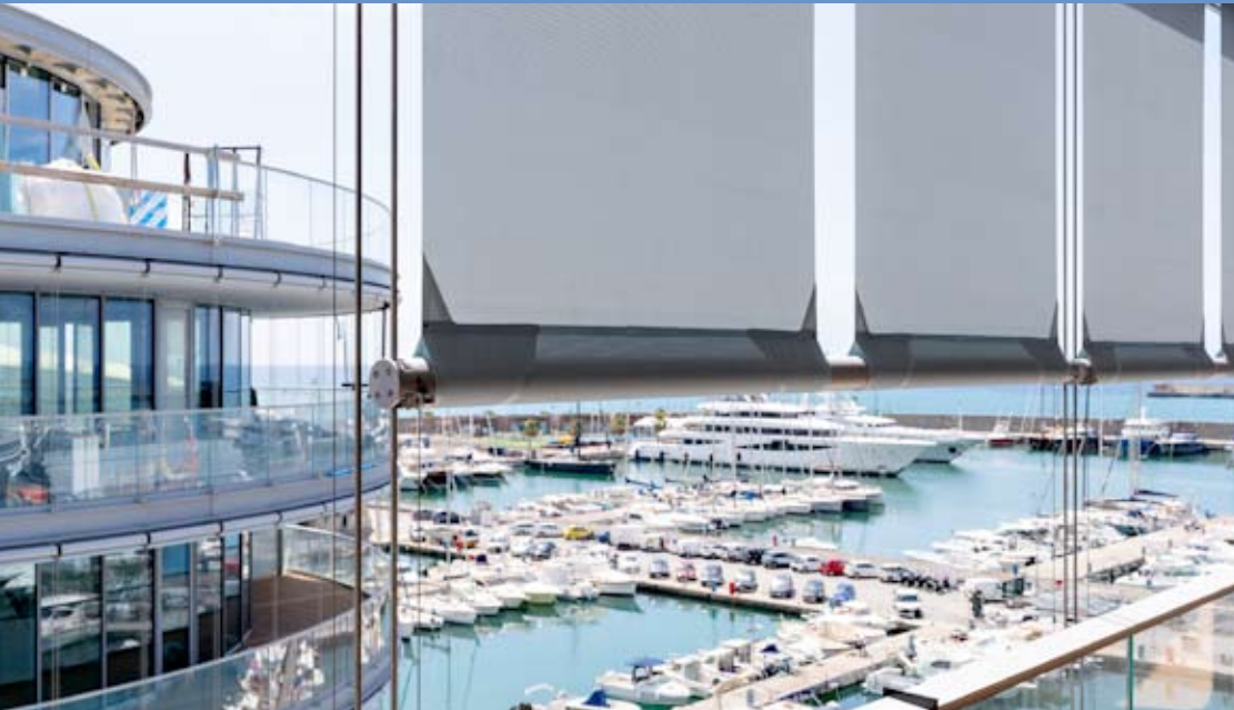
Foto oben und Foto links: Der Wohnkomplex „Waterfront di Levante“ in Genua liegt direkt am Meer und erhielt deshalb einen außenliegenden Sonnenschutz aus insgesamt 1.280 Rollos.
