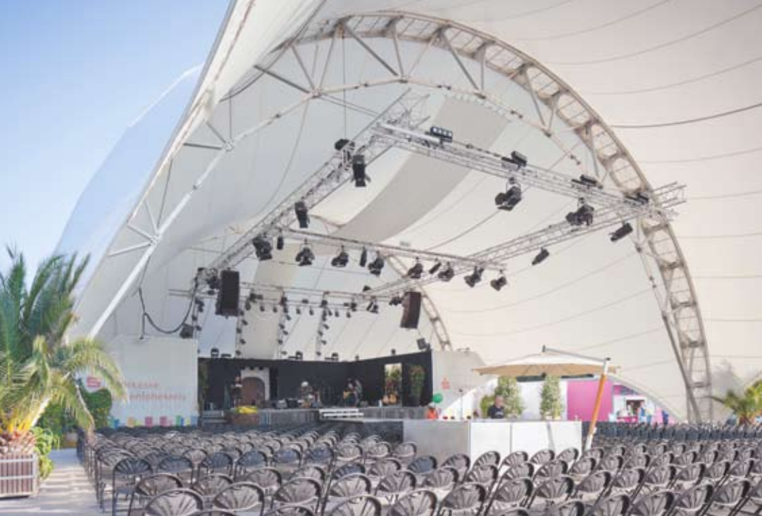
Diese Bühnen- und Zuschauerüberdachung aus PVC-Planen macht Konzerte und Aufführungen selbst bei schlechtem Wetter möglich. Foto: Tent Dimensions
