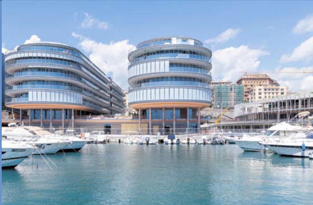
Foto oben und Foto links: Der Wohnkomplex „Waterfront di Levante“ in Genua liegt direkt am Meer und erhielt deshalb einen außenliegenden Sonnenschutz aus insgesamt 1.280 Rollos.
