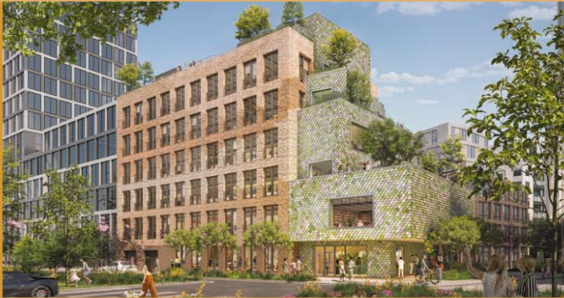
Die zweigeteilte Fassade des Bürokomplexes setzt auf Recyclingbaustoffe. Links: recycelte rotbraune Klinkersteine, rechts: recycelte bunte PVC-Schindeln. Foto: MVRDV
