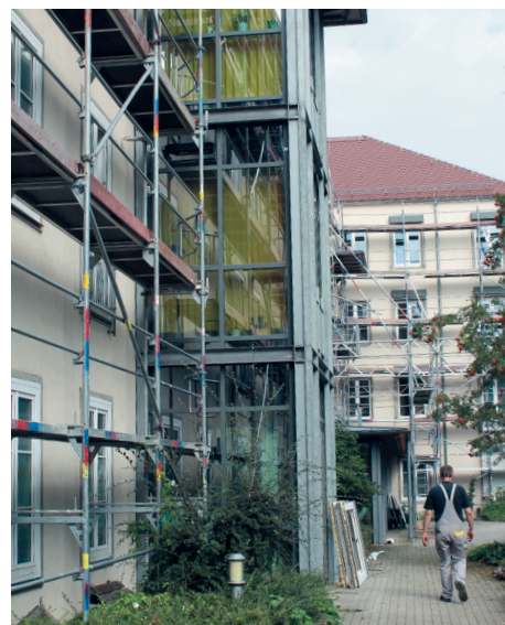
Insgesamt 205 alte PVC-Fenster wurden aus dem Wohnzentrum des Arbeiter-Samariter-Bundes ausgebaut und recycelt. Foto: Rewindo
